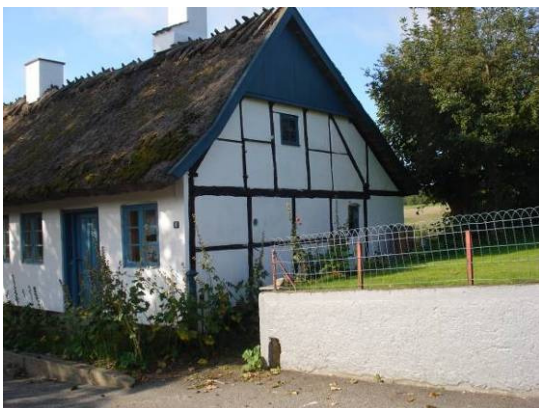
Gavl med bindigsværk, Brederødvej 8
