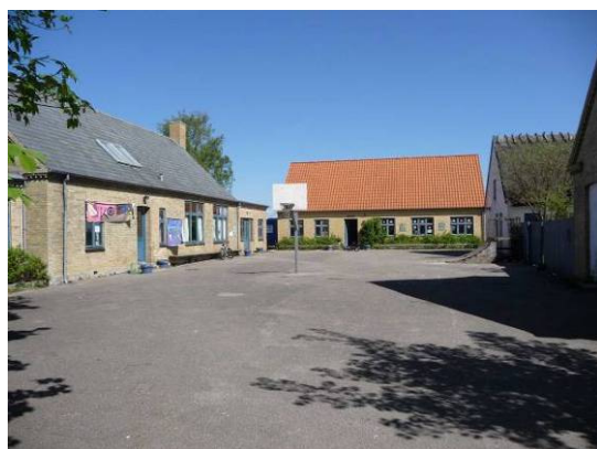
Skolegården til Brederød gamle forskole, bygningen bagerst i billedet er fra 1998
